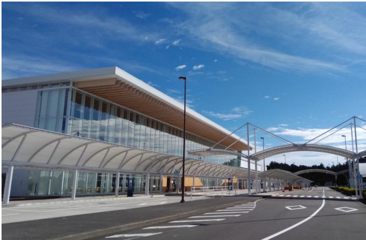
ターミナルビル外観
