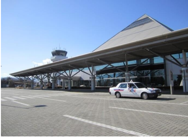
ターミナルビル外観
