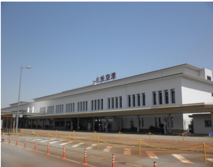
ターミナルビル外観
