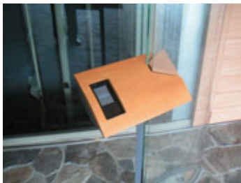
玄関インターホン（携帯端末での開閉制御）
