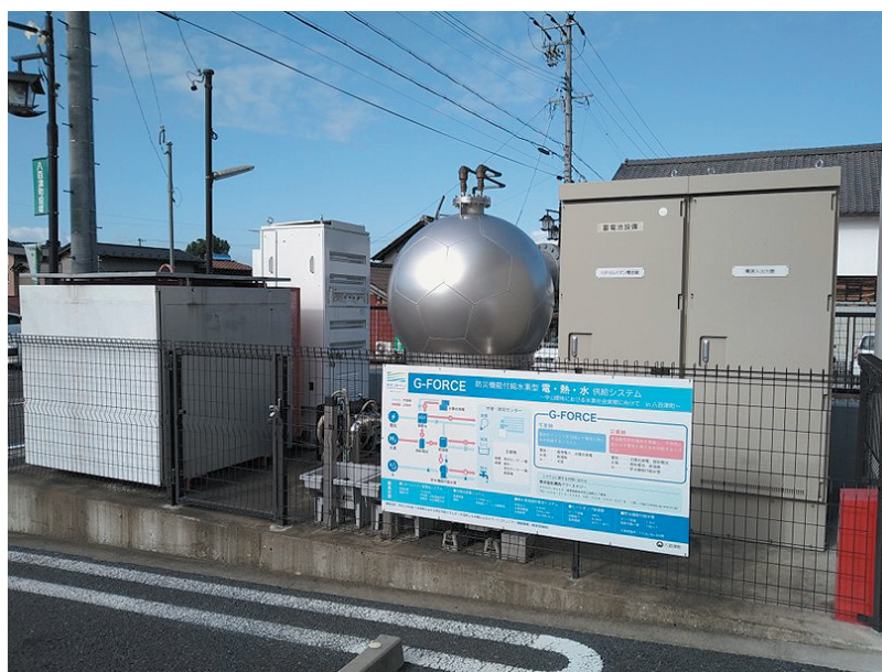
図3 八百津町防災センターへ設置された純水素型燃料電池コージェネレーションシステム
