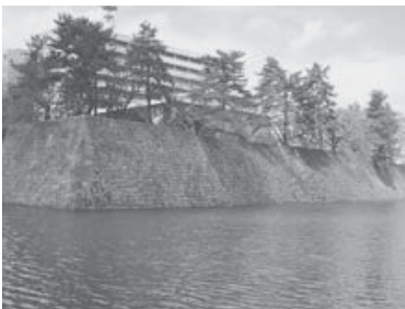
結城秀康が築城した福井城。切石積みの石垣と水量豊富な内堀が美しい。建物は福井県庁。
