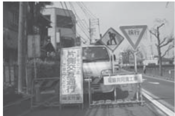
資料10 「COP10」の開催に間に合うよう名古屋城周辺では電線の地中化工事が急ピッチ。
