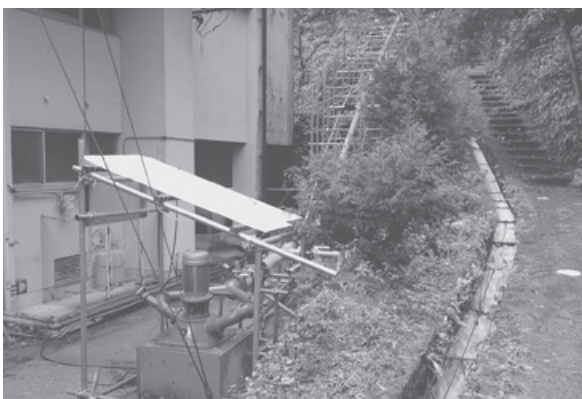
写真22 2kWの小水力発電システム。右に見える流れの水が水車に送られて発電に利用される予定
