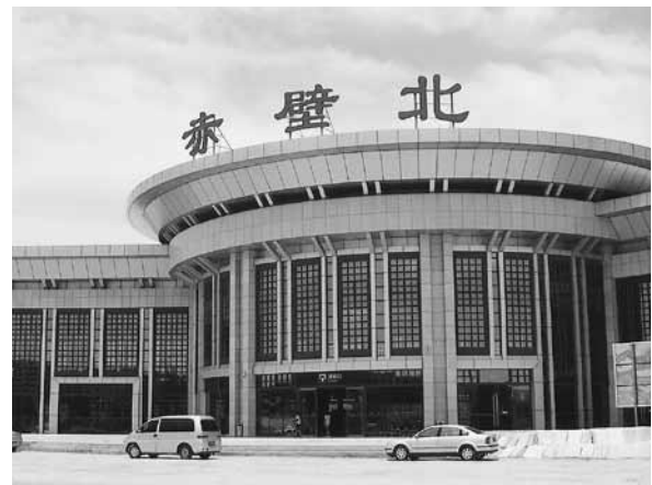
赤土の海に浮ぶ鼎型駅舎
