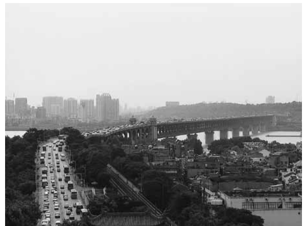
黄鶴楼から武漢長江大橋を見る
