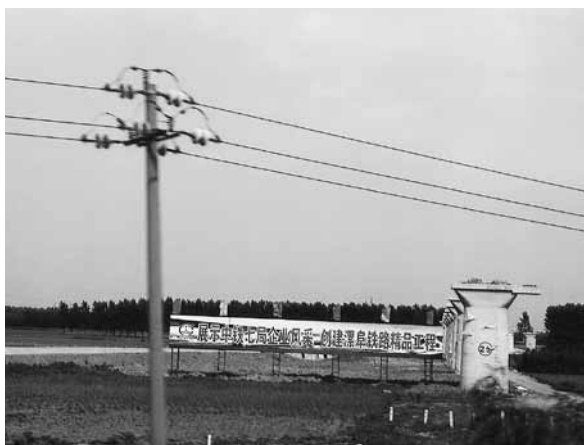
立体高速鉄道の建設現場
