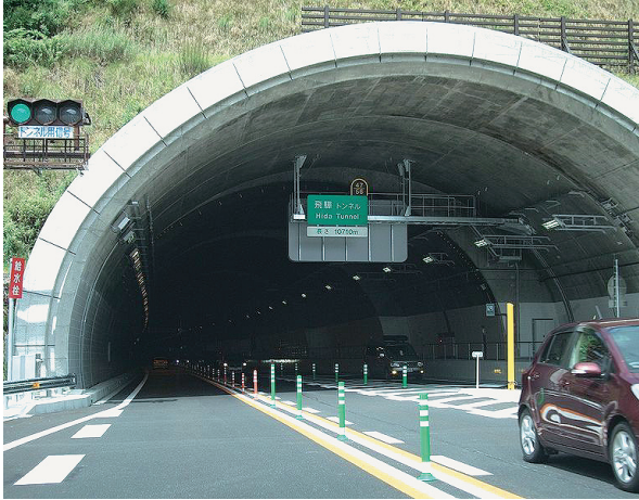
飛騨トンネル河合坑口
