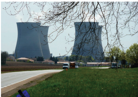
（写真⑦）リヨン郊外の原子力発電所
