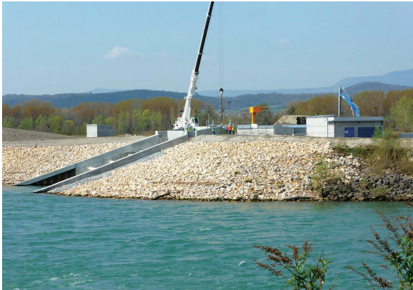
（写真⑧）建設中のローヌ川水力発電施設
