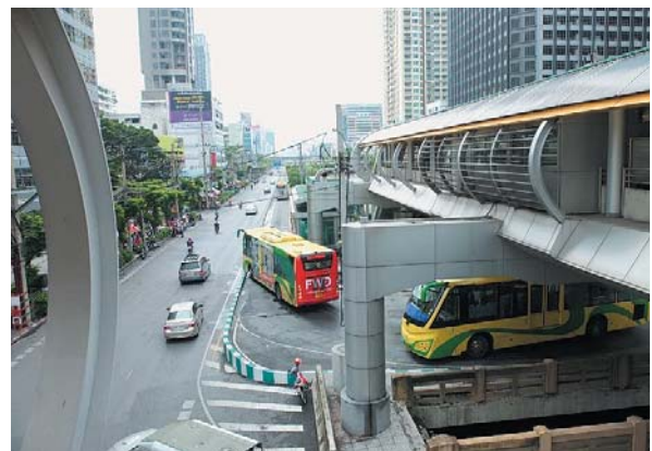
バンコク BRT（新世代バス・システム）のターミナル（サトン通り）
