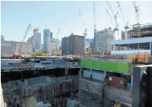
図26 ハドソン・ヤード 建設現場
