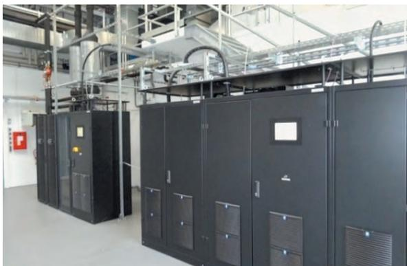
写真9 水素燃料電池、蓄電池、キャパシタから成るシステム
