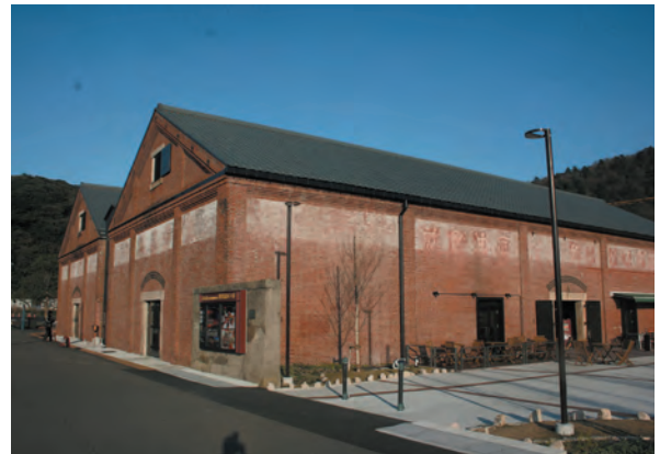
建設されて110年となる赤レンガ倉庫
