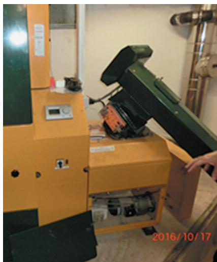
写真3 ペレットボイラー（左）とカロリーメーター（右）
