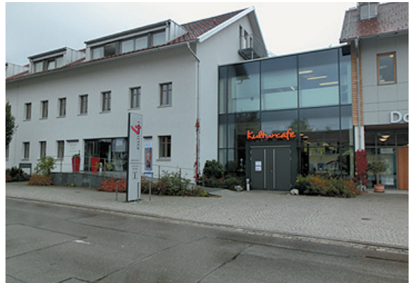
写真7 400kW木質チップボイラーが設置されている村営ホテル
