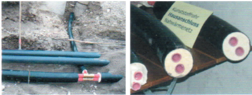
写真8 熱供給配管の埋設状況と配管の断面
