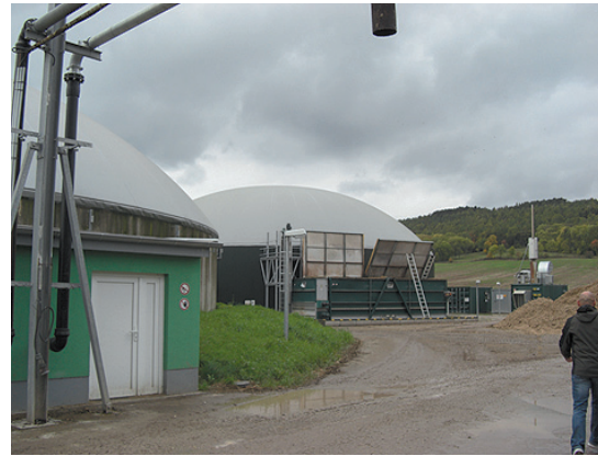
写真11 バイオガスエンジン（左）とバイオガス発酵槽（右）
