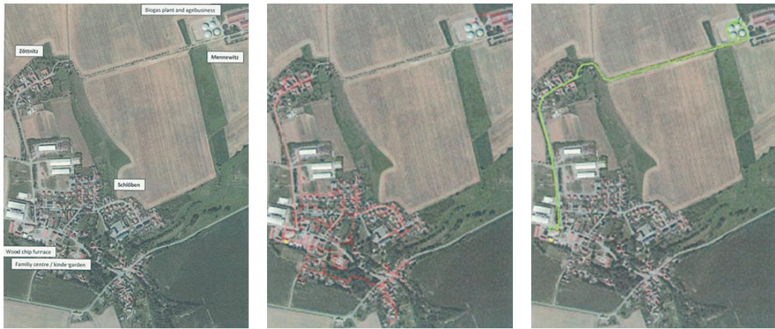
写真10 Schlöben村全景（左），熱供給配管網（中央），バイオガス配管網（右）
