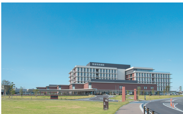
写真4 新市民病院の外観
