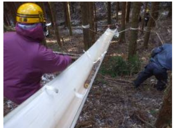
SWCによる集材作業の様子
