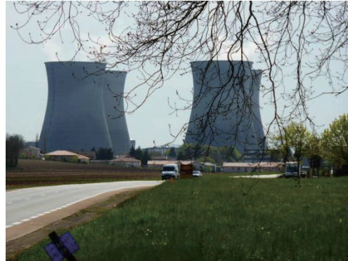
(写真⑦) リヨン郊外の原子力発電所
