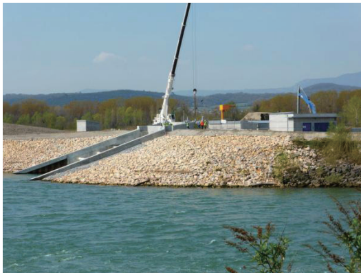
(写真⑧) 建設中のローヌ川水力発電施設
