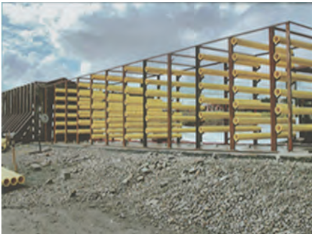
写真 2 - 1 厨房内のガス爆発を模擬する野外実験装置（実験時には鉄骨の構造物の周囲をビニールシートで覆い、内部に水素混合ガスを注入・爆発させ、水素濃度の違いによる爆発の被害の違いを評価する。黄色のチューブは障害物を模擬したもの。）
