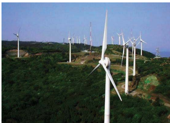
図4. 23 「青山高原ウインドファーム」の全景 14) (出典：三重県雇用部)
