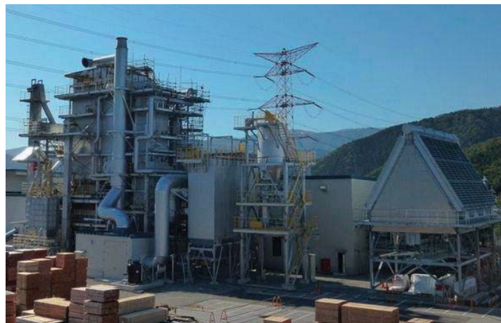
図4. 29 「いぶきグリーンエネルギーバイオマス発電所」の全景 15) (出典：いぶきグリーンエネルギー)
