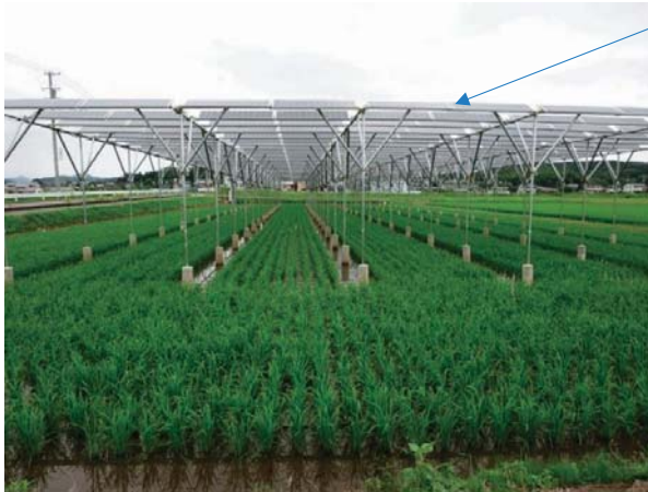
図5.5 営農型（水田）太陽光発電 美濃加茂第一発電所（写真提供 ㈱野田建設）
