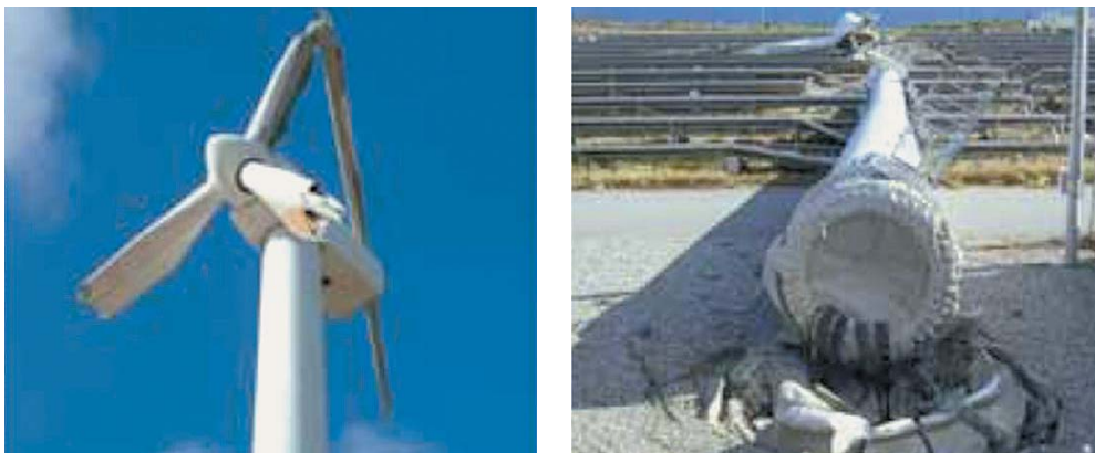
図 6. 3 台風に伴う強風により破損した宮古島の風車 6)
