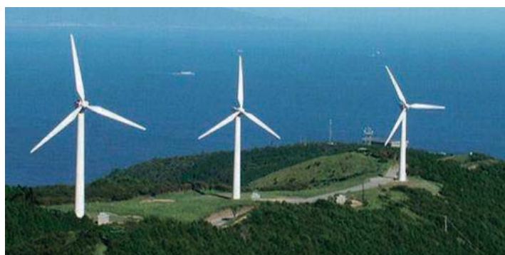
図4. 17 「東伊豆町風力発電所」の全景 12) (出典：東伊豆町企画政策課)
