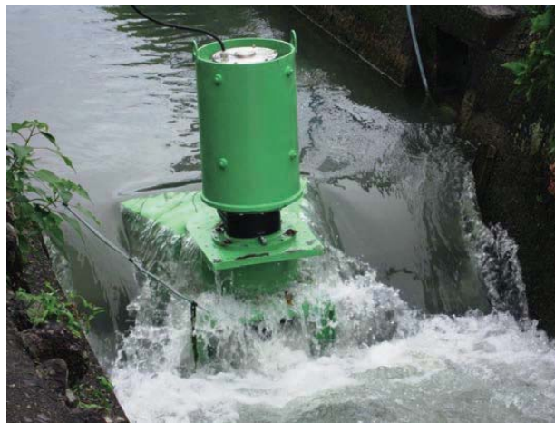
図8. 7 相反転方式水車発電ユニットの実証試験の様子
