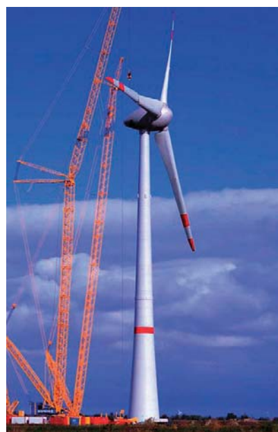
図6. 7 大型風車（ロータ径126m，出力5 MW，ドイツ）
