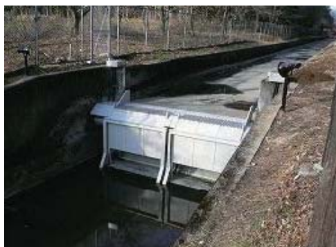
(a) 水車設置完了時
