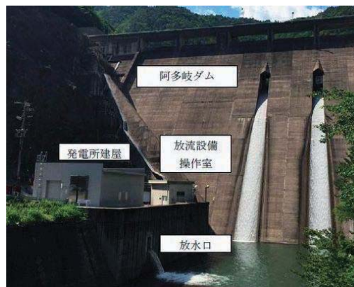
図4.13 「阿多岐水力発電所」の小水力発電設備 11) （出典：中部電力）
