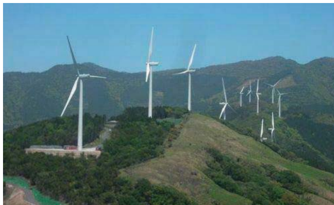
図4. 16 「東伊豆風力発電所」の全景 12) (出典：東京電力)
