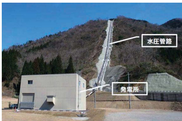
図4.1 「片貝別又発電所」の全景 1) （出典：北陸電力）
