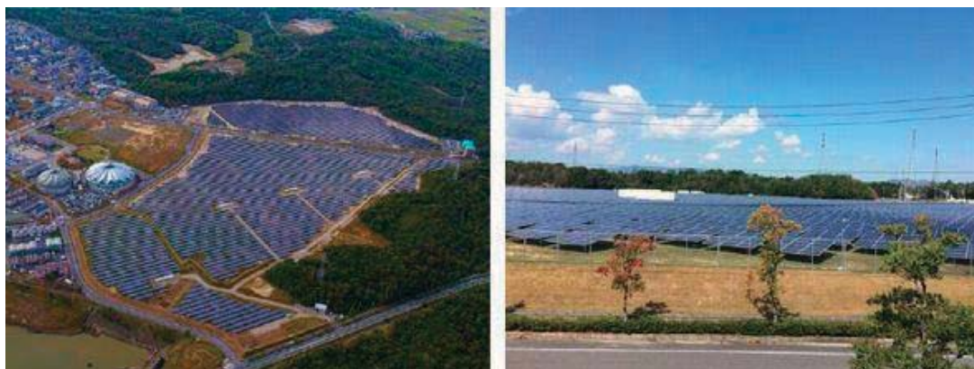
図4. 24 「近鉄伊賀ゆめが丘ソーラー発電所」の全景 (左)、太陽光パネルの設置状況 (右) 14) (出典：近畿日本鉄道)
