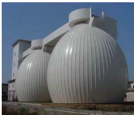
図4. 6 消化ガスを貯蔵するタンク 10) (出典：石川県環境部)
