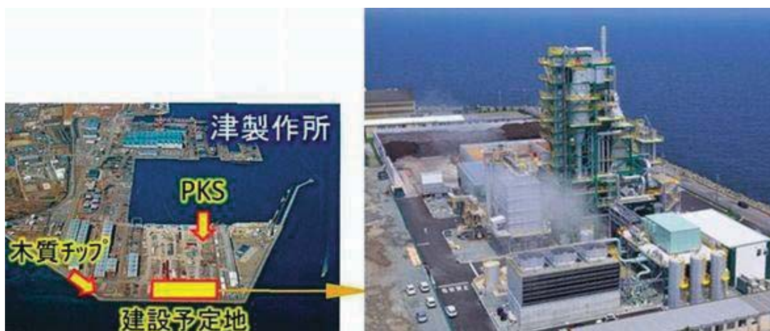
図4. 26 「グリーンエナジー津」の発電設備の全景 8) （出典：JFEエンジニアリング）
