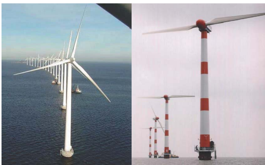
(a) コペンハーゲン（デンマーク）の沖の3枚翼風車 (b) アイセル湖（オランダ）の2枚翼風車
