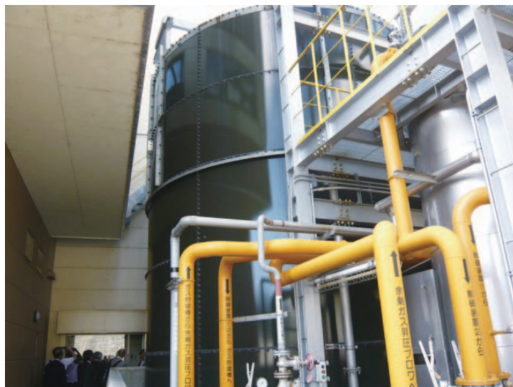
図 2. 4. 6 ガス貯留槽
