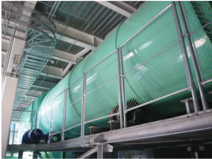
図2.5.4 高効率ドラム式選別装置
