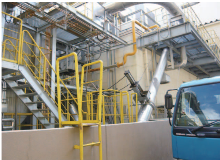
図2.4.8 残渣排出配管
