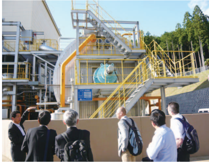
図 2. 4. 4 メタン発酵槽①
