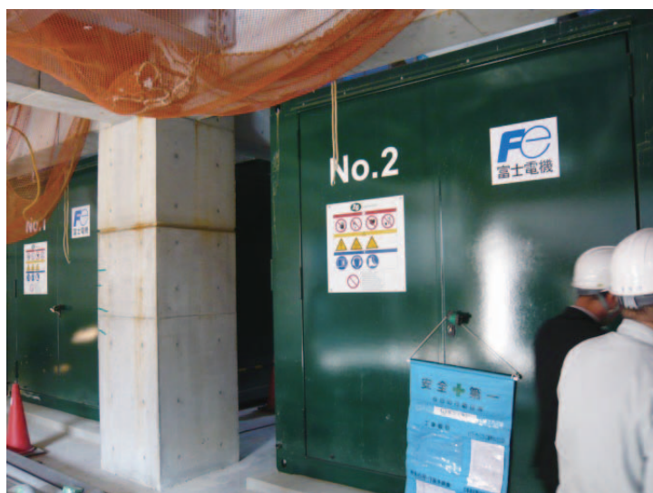
図 2.5.8 ガスエンジン発電機
