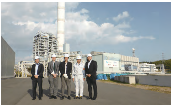
図表 2-9 プラント写真①<石炭ガス化設備、空気分離設備>
