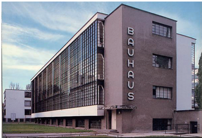
図 5.4-1 バウハウス・デッサウ校舎 現存する世界最古のカーテンウォール建築物（1926年）
