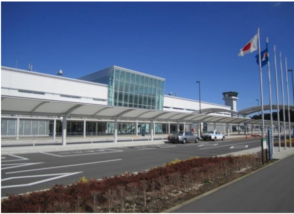
ターミナルビル外観
