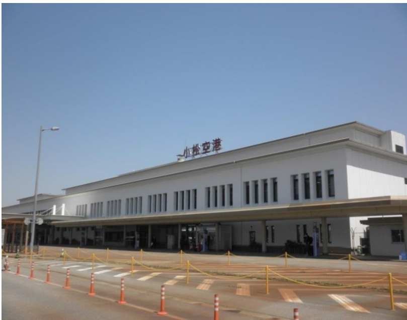
ターミナルビル外観
