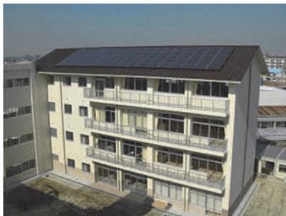
安城南中学校（愛知県安城市）
