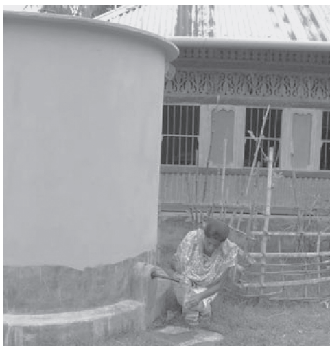
写真4 天水研究所製 開発した4.4トンの雨水利用タンク (株式会社天水研究所提供)
