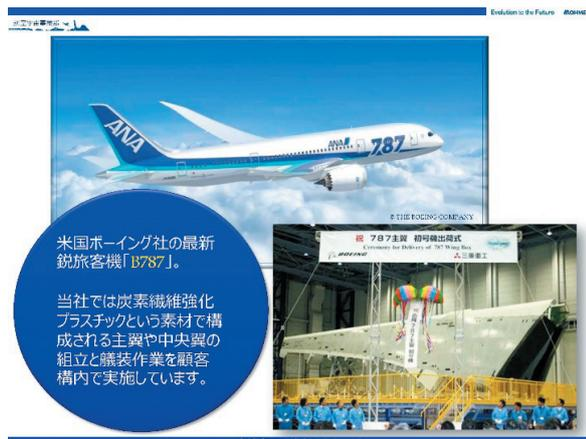
ボーイング787型機（愛称：ドリームライナー）の主翼の組立、<sup>きそう</sup> 艀装作業を行っています。主翼は全て炭素繊維複合材を使用し、三菱重工の大江西工場で組立をしています。当社の担当作業は、一部狭いところの中腰作業などもあり、作業者に配慮された設計になっていないところが残念です。
