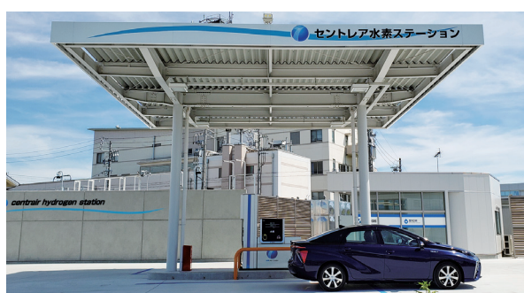
図表5-3 セントレア水素ステーション
