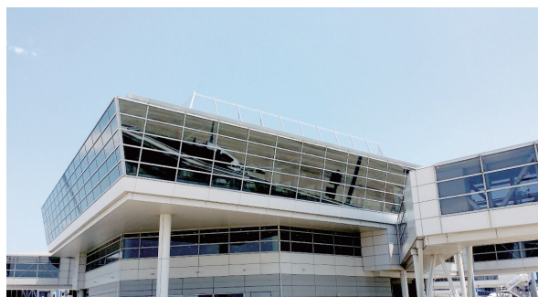
図表5-2 光触媒ガラスを使用した第1ターミナルビル
