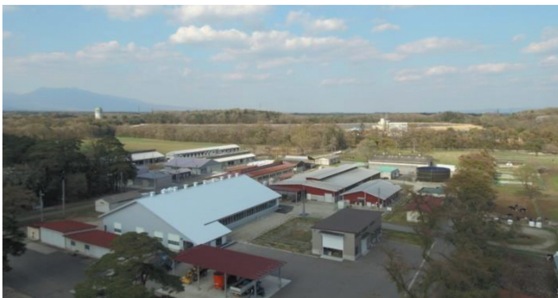
図1. スマート畜舎全景
