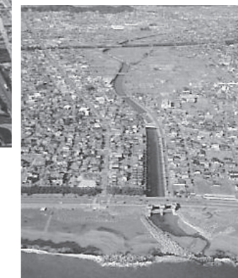
■ 大谷川放水路 (より多くの水を流せるよう河床の整備を進めている)
