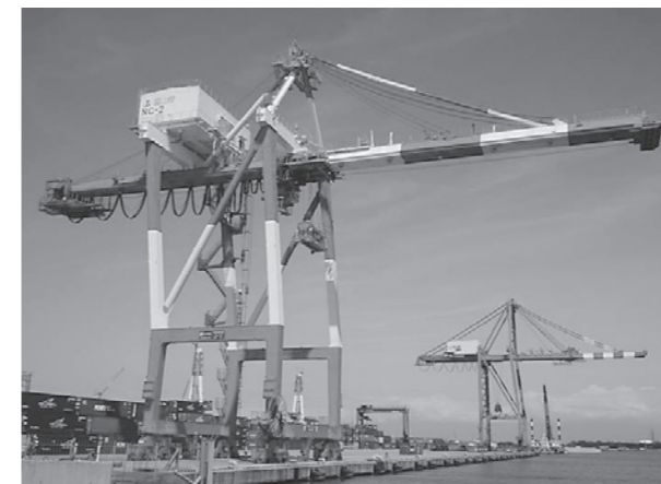
■（新湊地区）多目的国際ターミナルの整備
