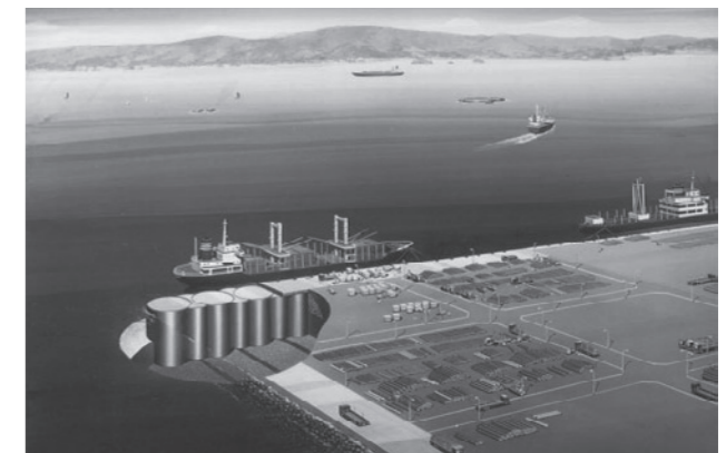
■ 軟弱な地盤に対応した構造(鋼板セル式)により整備
