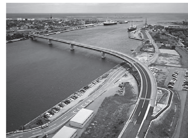
■（伏木地区）臨港道路伏木外港1号線の整備
