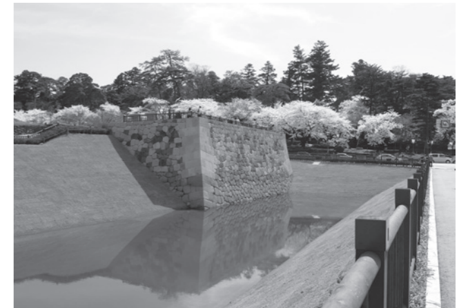
■ いもり堀（2010年4月10日完成供用）
