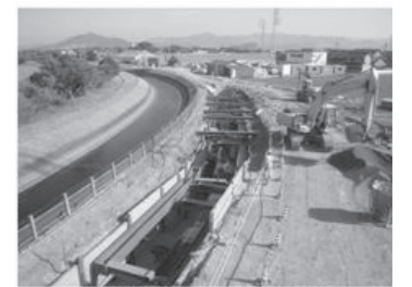
■ 併設管水路埋設工事
