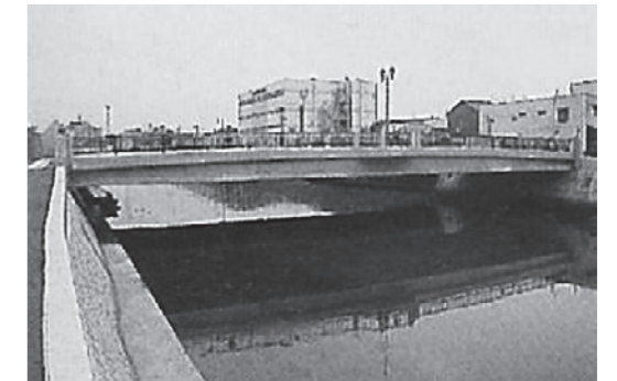
■ 河道改修 (流水の阻害となっていた橋を架け替え)
