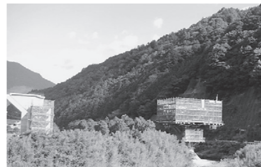
■ 工事中の井戸谷橋(三重県度会郡大紀町)
