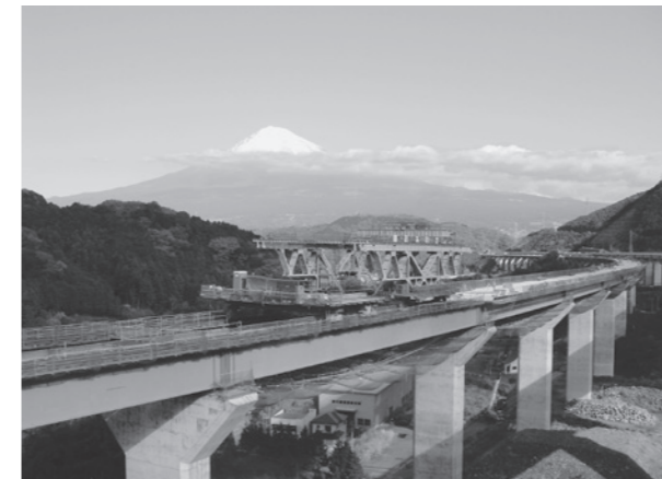
■ 鎧田川橋（静岡県富士市）
