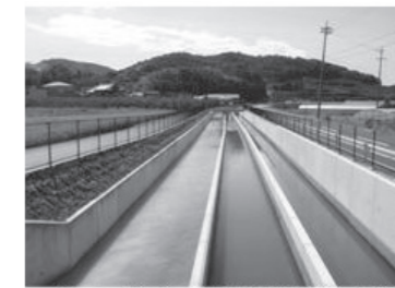
■ 改修された牟呂松原幹線水路
