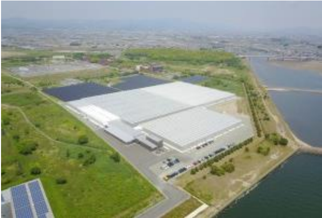
図 5-21.イノチオファーム豊橋施設全景(イノチオみらい提供)
