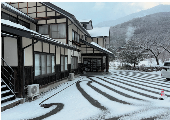
図2 地熱温水を利用した駐車場の融雪の様子
