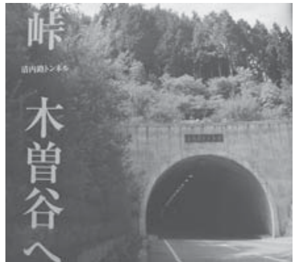
国道256号線・清内路峠にある「清内路トンネル」（全長1,642m）。このトンネルが1999年7月に完成する前は、木曾谷へ下りるためには、清内路峠を越える必要があった。（清内路支所提供）
